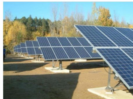
Figure 10. Structures fixées à des longrines béton
